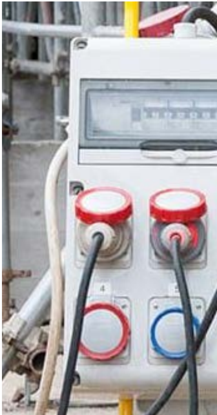
Obras e instalaciones efimeras
