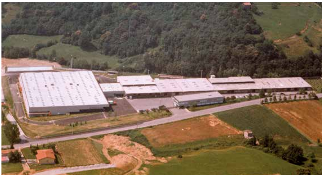
Con la palazzina direzionale si completa l'insediamento di Cenate Sopra With the headquarters building, the Cenate Sopra establishment is finished.
