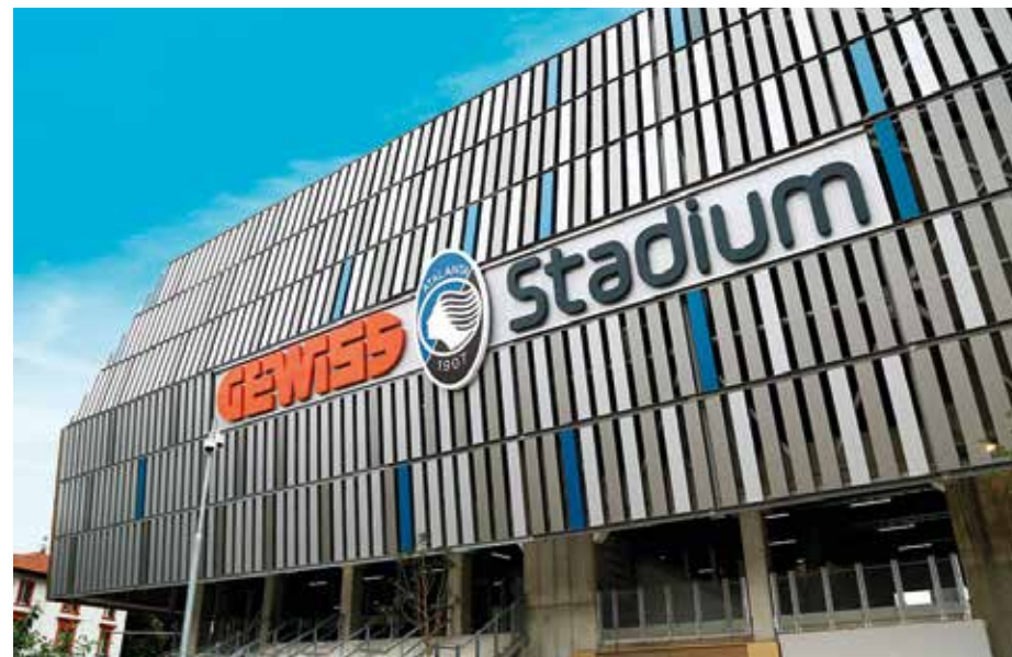
Gewiss Stadium, un laboratorio di ricerca applicata dell'impiantistica GEWISS Stadium, a laboratory of applied research of engineering plant
