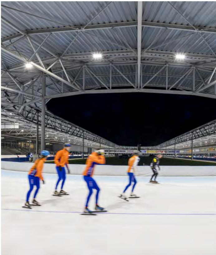
Pour l'éclairage de la patinoire de 400 m de Meent, Van der Laan a de nouveau collaboré avec PERFORMANCE iN LIGHTING et a choisi des projecteurs LED de la gamme GUELL 3. Les projecteurs sont équipés du système de contrôle DALI qui permet de régler l'éclairage des pistes dans une configuration pour les loisirs, l'entraînement ou la compétition. De plus, la ligne d'arrivée des 1000 m est équipée d'un éclairage supplémentaire pour améliorer la photo finish.
