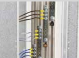
Barretta connessione interruttori modulari
