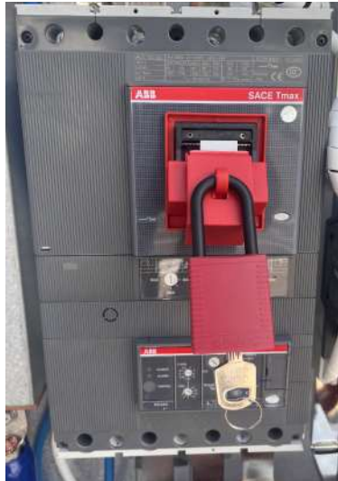
Abbildung 23. Freischalten des Leistungsschalters
