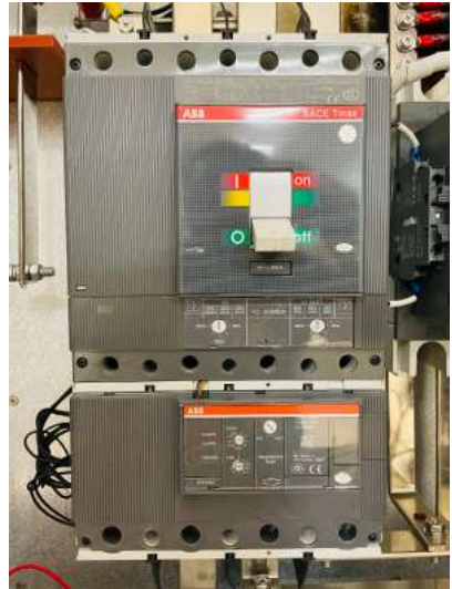
Abbildung 29. Freischalten des Leistungsschalters
