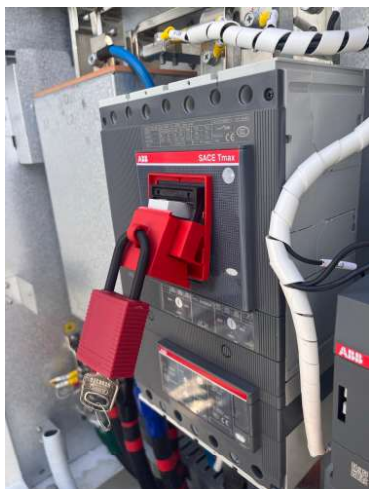
Figura 24. Deblocare disjuncător
