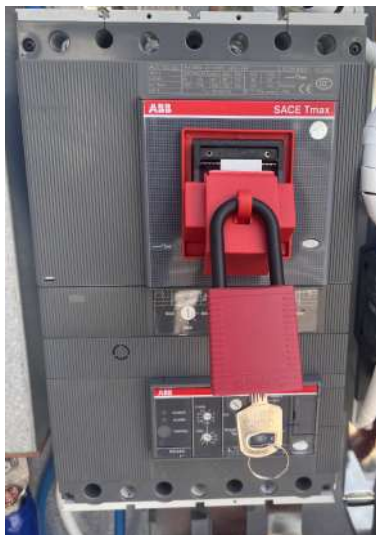
Figura 23. Deblocare disjuncător
