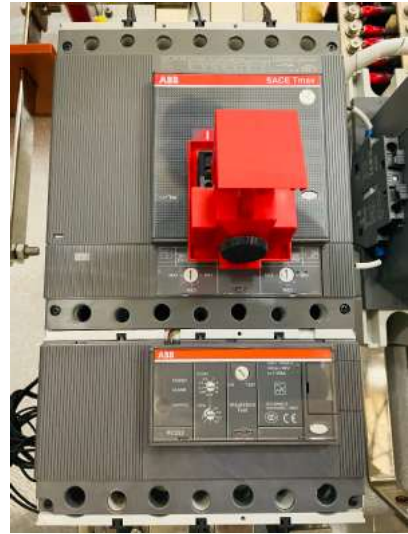
Abbildung 26. Verschlussklappe geöffnet Abbildung 27. Entfernen der Verschlussklappe
