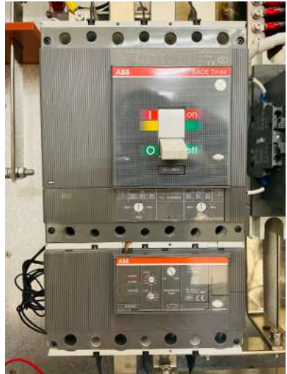
29. ábra Megszakító kioldása
