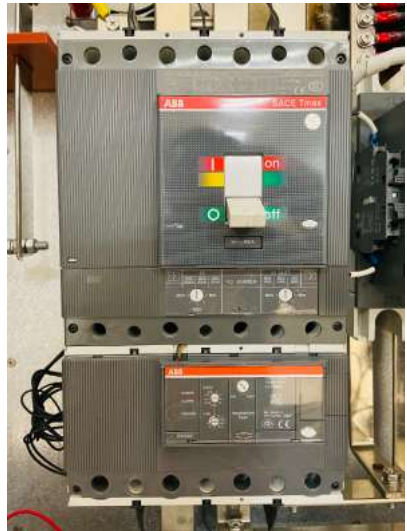
Afbeelding 29. Vermogensschakelaar ontgrendelen
