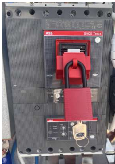
Afbeelding 23. Vermogensschakelaar ontgrendelen
