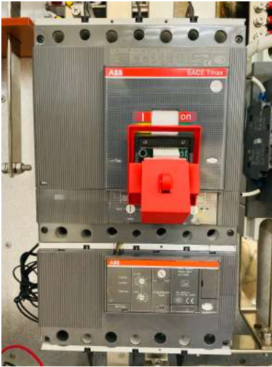
Afbeelding 26. Vergrendelklep open
