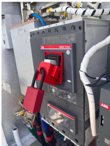
24. ábra Megszakító kioldása
