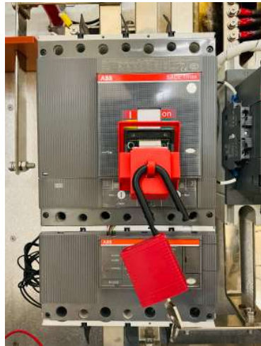
Figura 25. Desmontaje del bloqueo
