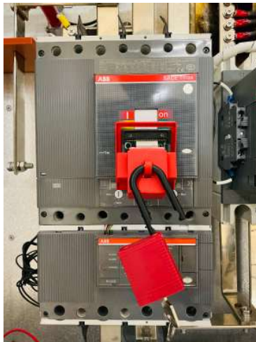
25. ábra Zár eltávolítása
