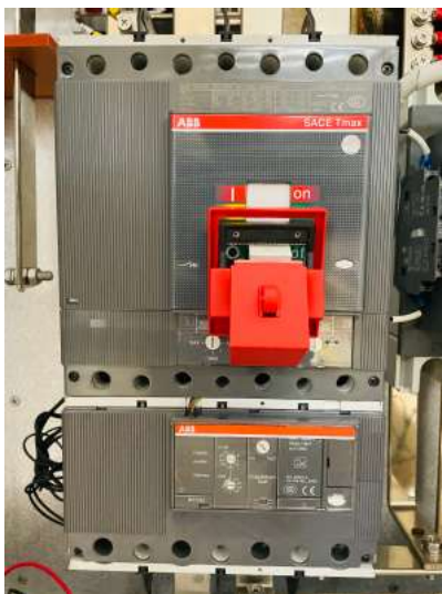
Figura 26. Solapa de bloqueo abierta
