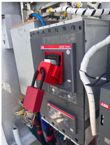
Abbildung 24. Aufschließen des Leistungsschalters
