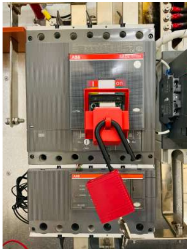
Abbildung 25. Entfernen des Vorhängeschlosses
