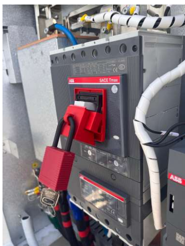
Figura 24. Sblocco interruttore
