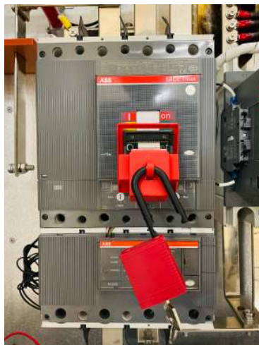
Afbeelding 25. Slot verwijderen
