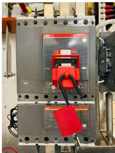
Figura 25. Rimozione del blocco
