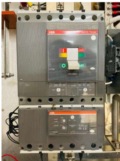
Figura 29. Deblocare disjuncteur
