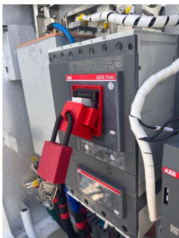
Figure 24. Déverrouillage du disjoncteur
