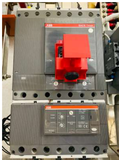
Figura 27. Îndepărtarea clapetei de blocare
