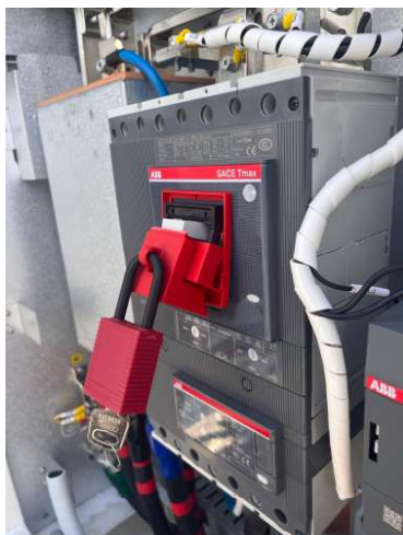
Afbeelding 24. Vermogensschakelaar ontgrendelen
